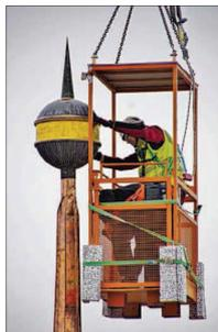
Im zweiten Arbeitsgang wurde die Kugel befestigt.
