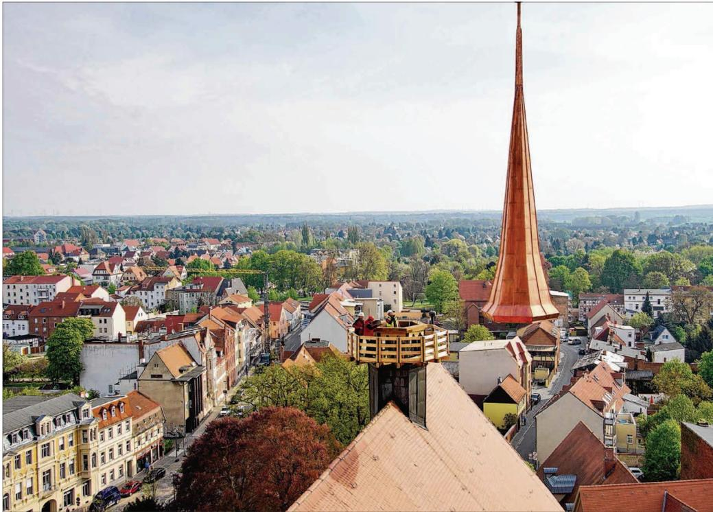
Präzisionsarbeit war gestern erforderlich, um den 1,2 Tonnen schweren Dachreiter auf dem Dachstuhl der Marienkirche in etwa 40 Metern Höhe zu montieren. Die Vorarbeiten waren gut, und das Wetter spielte bei dem Balanceakt auch einigermaßen mit.
