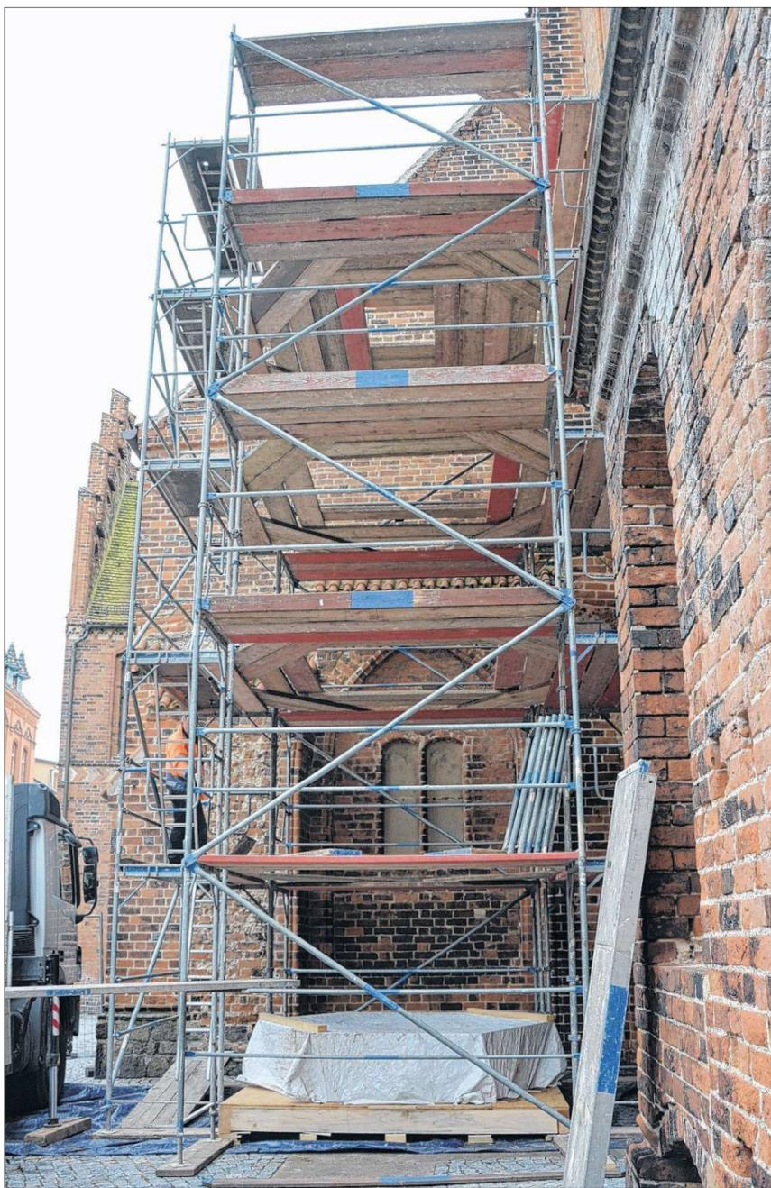
Gestern wurde das Gerüst aufgestellt, in dem jetzt Schritt für Schritt die vorgefertigten Teile des Turmhelms montiert werden - für jedermann sichtbar.
