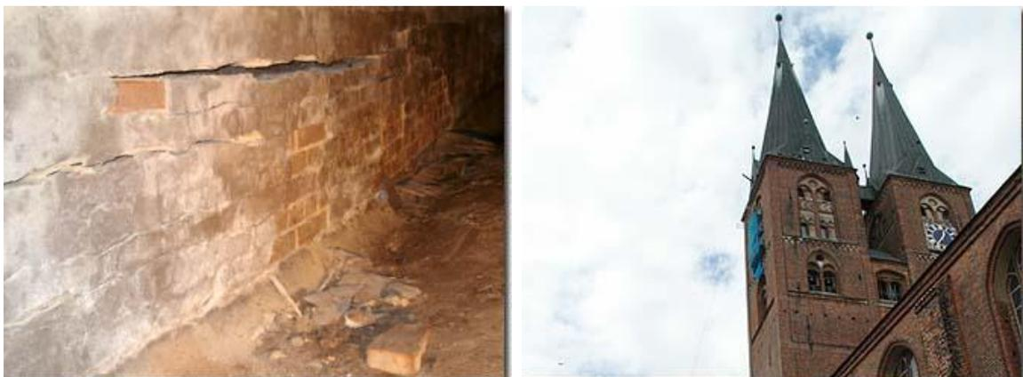
**links:** Elend im Untergrund: Die Wand des Heizungskanals unter dem Fußboden senkt sich und weist breite Risse auf.
