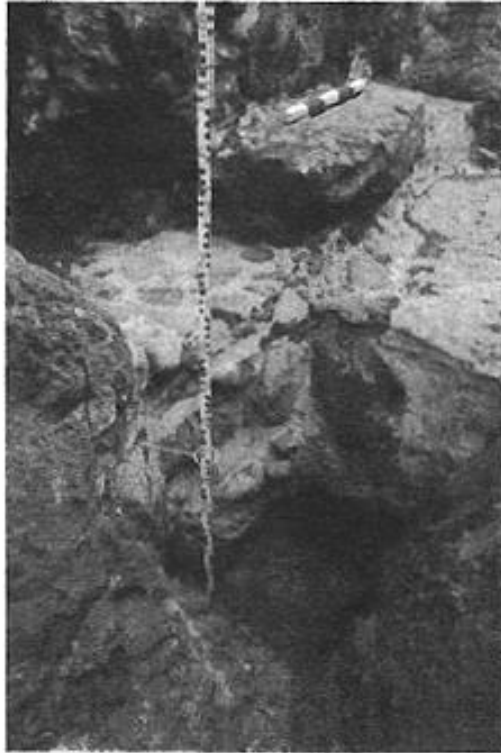
Abb. 14: Profil 23; Fundament, Mitte 14. Jh.
