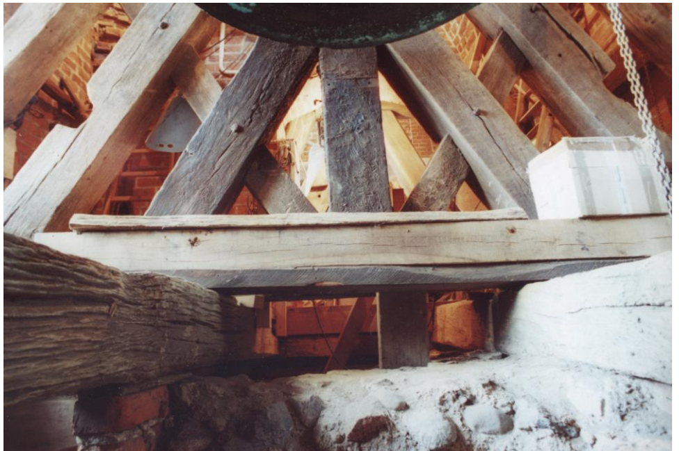
09.07.2000 Nordturm - Auflagerebene Glockenstuhl
