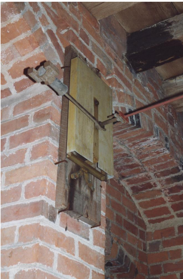
19.05.2000 Nordturm Ebene 6 - Zeigerantrieb des Ziffernblattes der westlichen Turmfront
