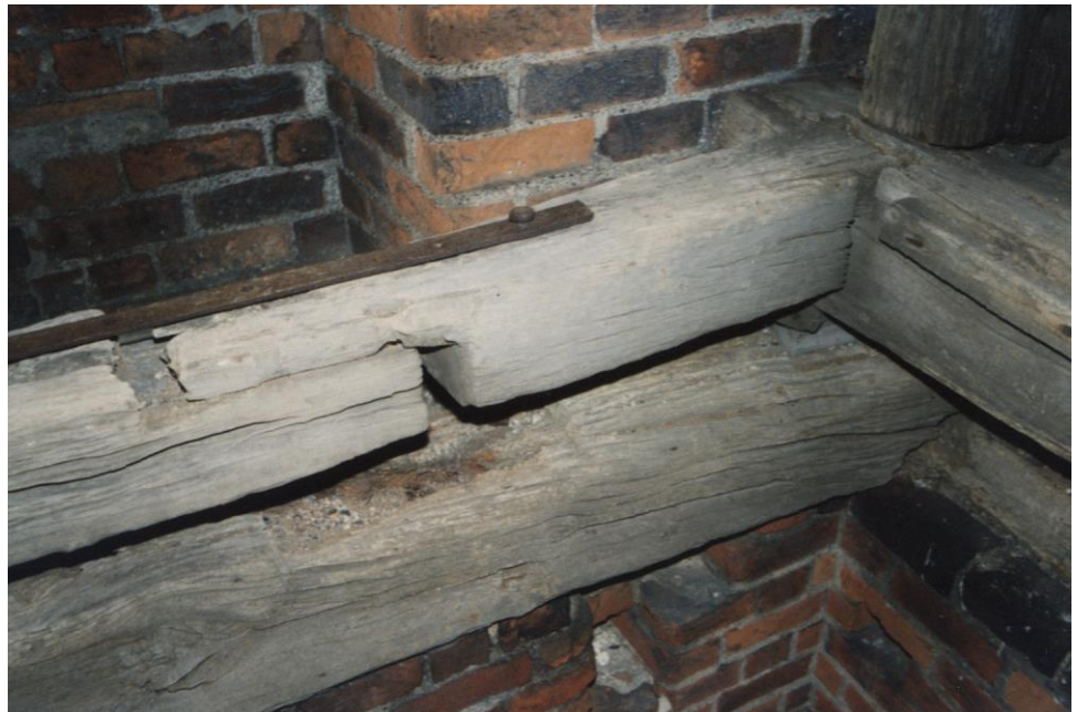
31.12.1998 Südturm - Grundschwellen des Glockenstuhles, Süd-Ost-Ecke
