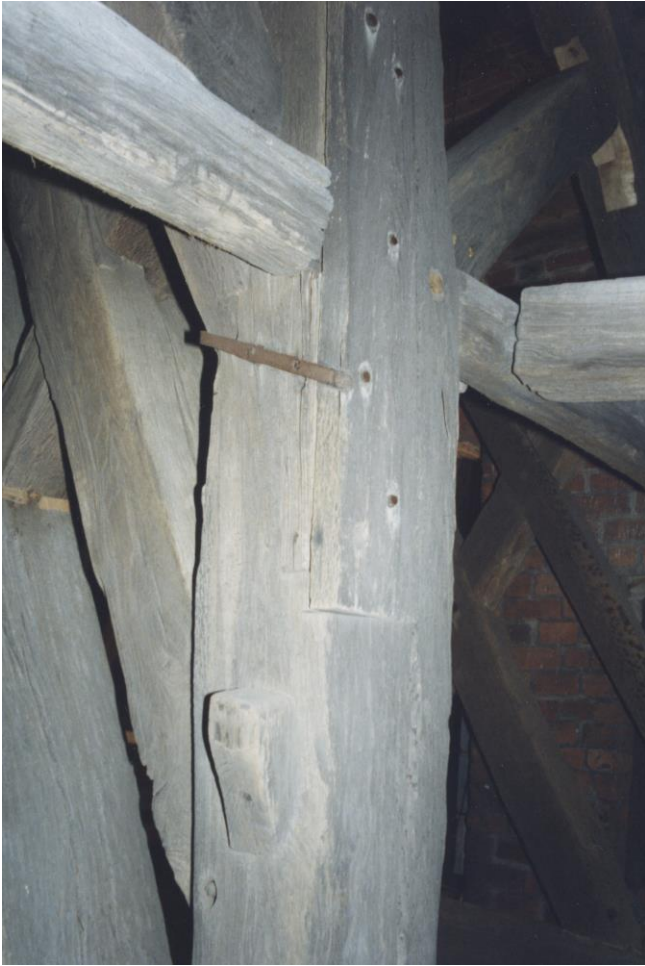
12.02.2000 Südturm - Glockenstuhl östliche Randstütze der Mittelteilung
