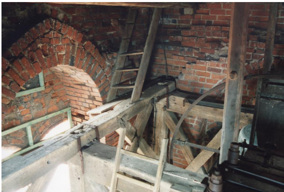
30.05.1996 Südturm - zweiteiliger Kastenglocken- stuhl von oben, Blick nach Nord-Westen
