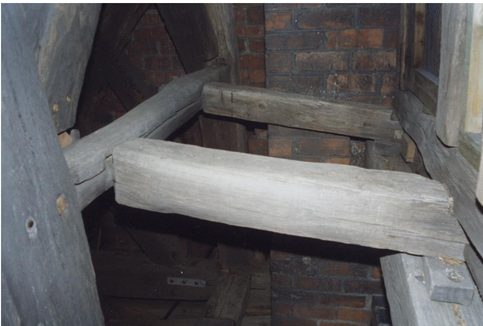
12.02.2000 Südturm - ehemaliges Chorgeläut zwischen dem Glockenstuhl (Randstütze sh. oben links) und den östlichen Schallöffnungen (sh. oben rechts)
