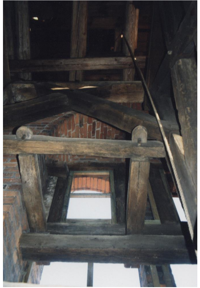
12.02.2000 Südturm - östliche Schallöffnungen mit ehemaligem Chorgeläut
