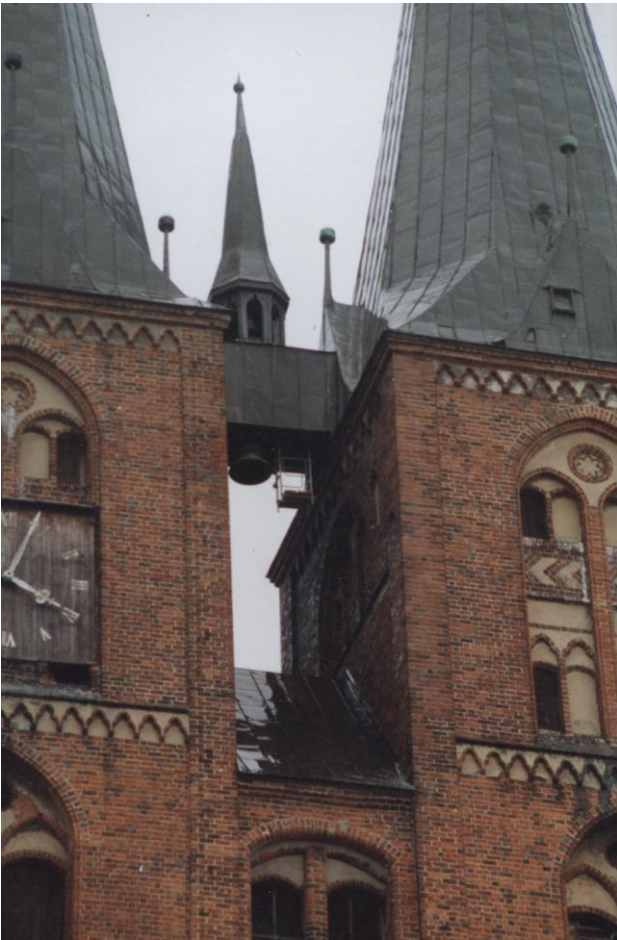
31.08.1998 - Stundenglocke zwischen den Türmen vor der Abnahme
