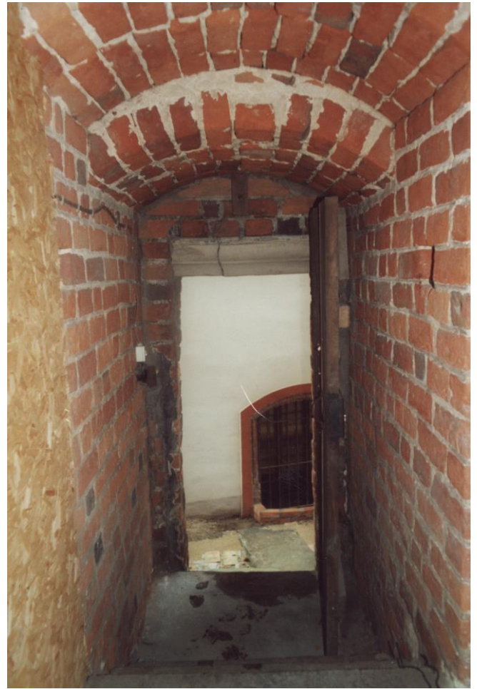
09.07.2000 - Südturm Ebene 1 Eingang an der Außentreppe Windgasse
