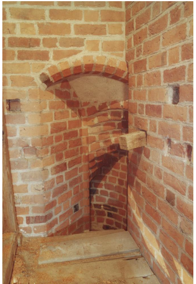
09.07.2000 Nordturn Ebene 6 - Wendeltreppe
