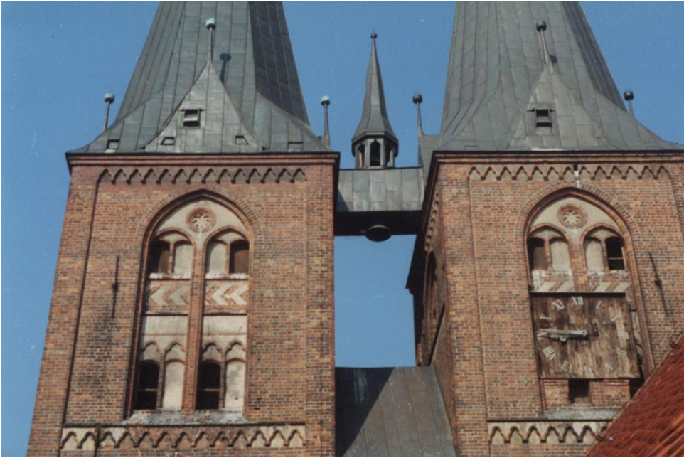
07.06.1996 - Turmobergeschosse von Osten Brücke mit Stundenschlagglocke und Dachreiter mit Viertelschlagglocke Ziffernblatt der Turmuhr
