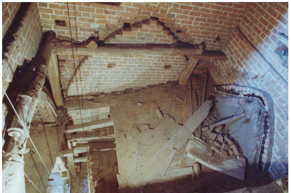
12.02.2000 Mittelturn - Blick von Ebene 3 (ohne Decke) auf die provisorische Zwischendecke über dem Blasebalg
