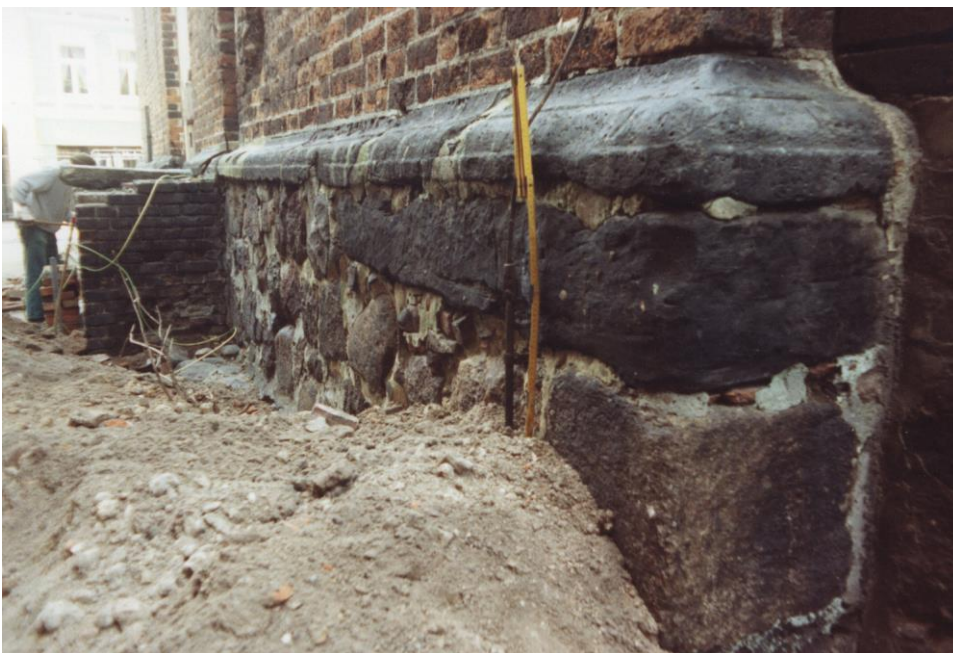
04.04.1996 - Turmsockel aus behauenen Findlingen und Außentreppe zum Südturm
