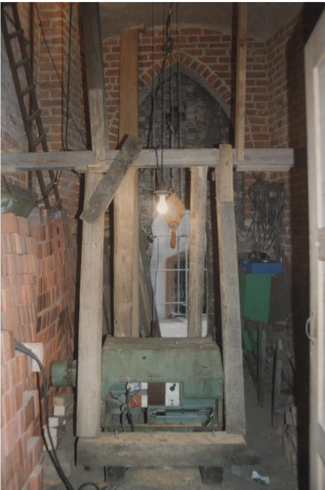
31.05.1997 Mittelturn, Ebene 0 - Blick nach Westen (Turmfront) mit Zugang
