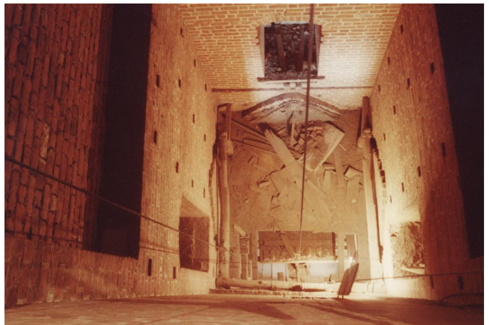
09.07.2000 Mittelurm - Blick von Ebene 4 durch die Montageöffnung nach unten
