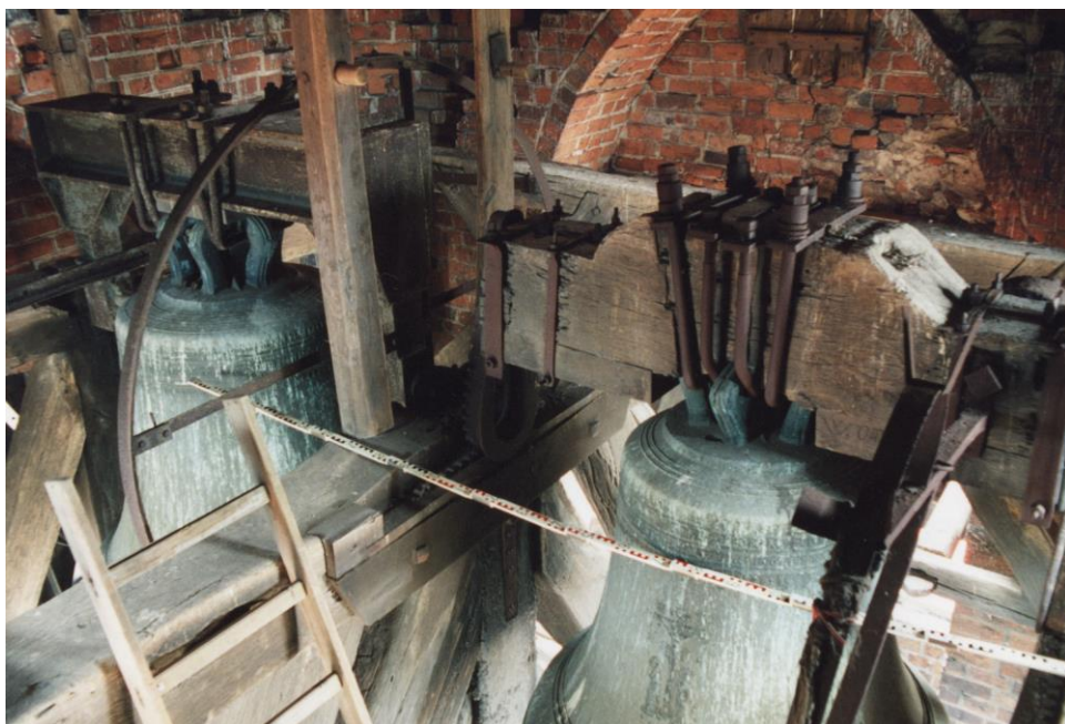
30.05.1996 Südturm - Faule Anna (links) am Stahljoch und Vespertglocke (rechts) am Ritterschen System
