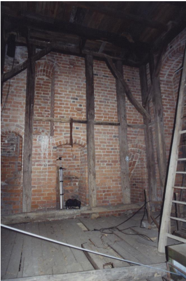
02.07.2001 Südturm Nordseite Ebene 7
