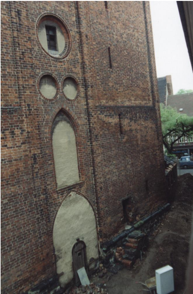
10.05.1996 - Windgasse zwischen Turmfront und Rathaus: vermauertes Westportal und Außentreppe
