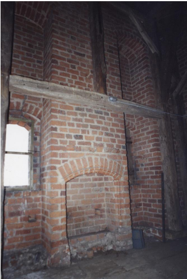
02.07.2001 Nordturm - Kamin Ostseite Ebene 7
