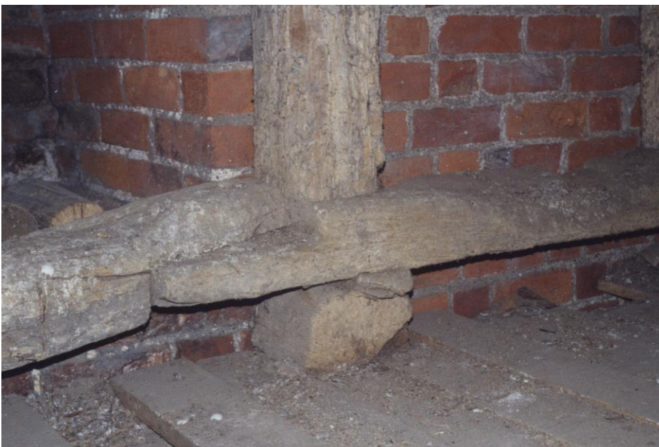
02.07.2001 Südturm Nordseite Ebene 7
