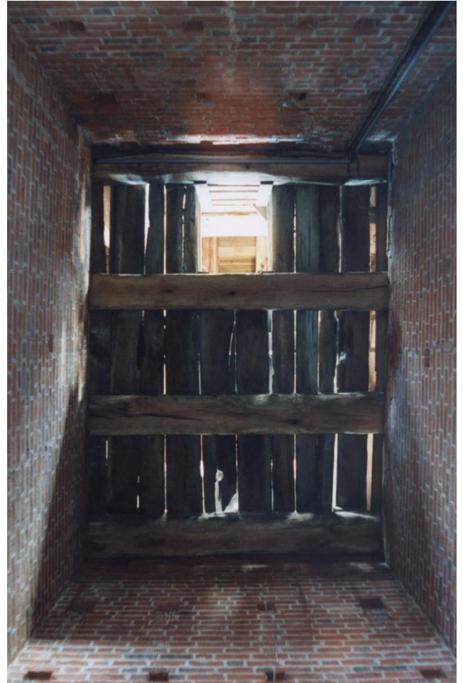
06.11.1996 - Mittelurm Ebene 4 Blick nach oben zur Glockenebene
