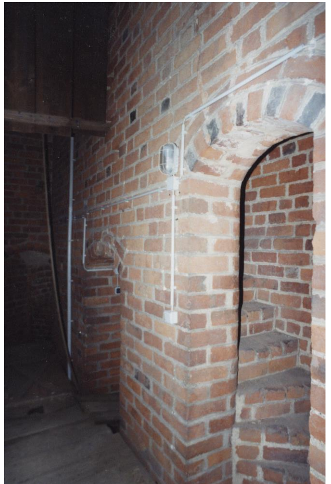
02.07.2001 Nordturm -Treppe Südseite Ebene 6
