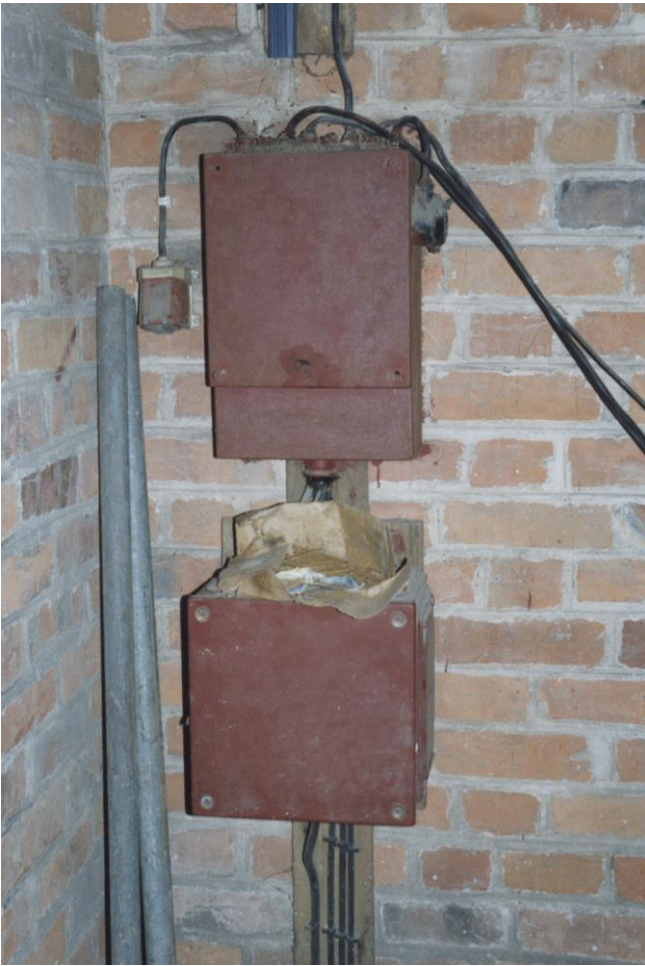
12.02.2000 - Wand zwischen Nord- und Mittelturn, Ebene 5: Schaltkasten der alten elektrischen Geläuteschaltung
