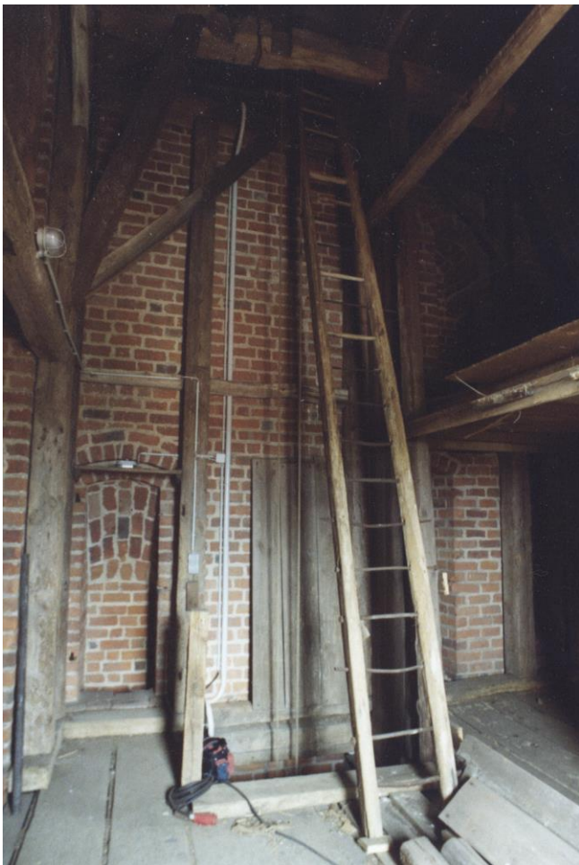
02.07.2001 Nordturm - Südseite Ebene 7
