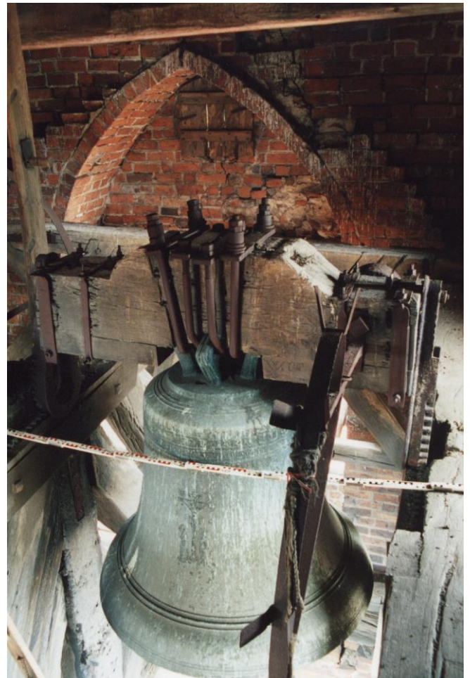
30.05.1996 - Vespertglocke von oben mit Aufhängung am Ritterschen System
