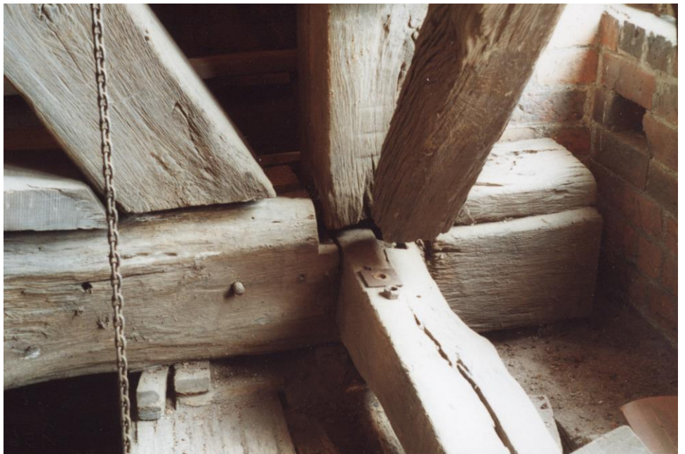
09.07.2000 Nordturm - lose Eckverbindung Glockenstuhl
