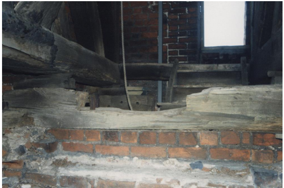
31.12.1998 Südturm - Mittelschwelle unter dem Glockenstuhl, Blick im Aufgang nach Süden
