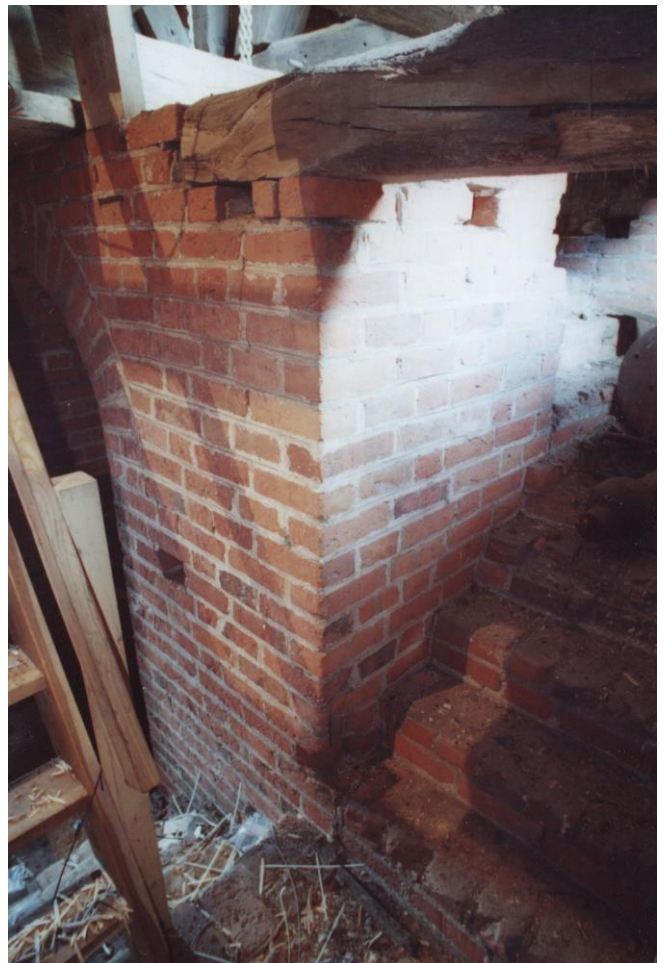
09.07.2000 - Nordturm, Treppe unter Glockenstuhl
