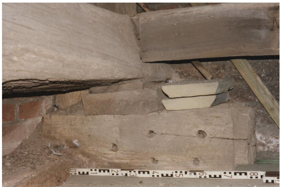
20.06.1997 Südturm - altes Glockenjoch (der Anna?) unter dem Glockenstuhl verbaut, Süd-West-Ecke
