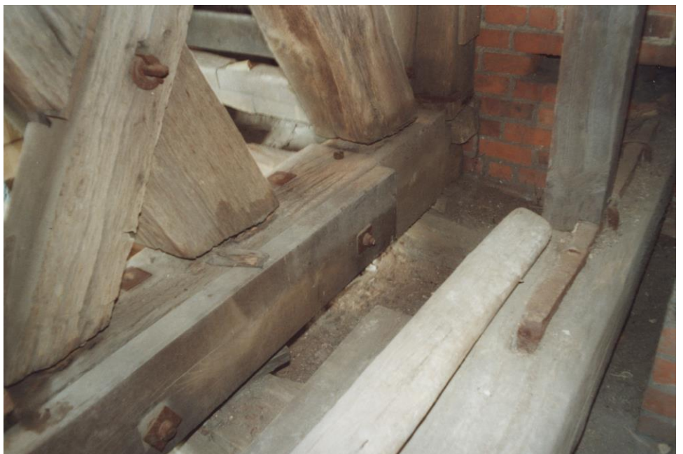
09.07.2000 Nordturm - Glockenstuhl, gezimmerte Schwellverbindungen und alten Reparaturstellen mit Eisenbolzen und -ankern
