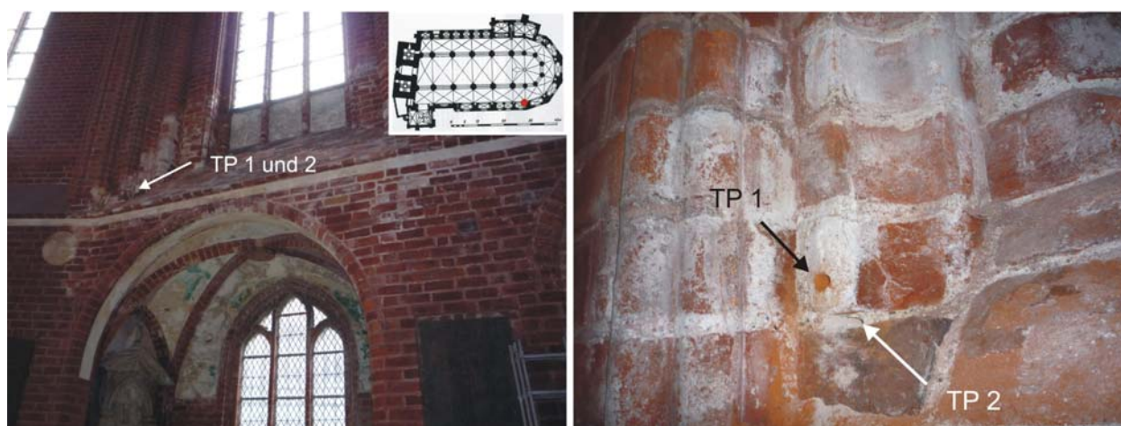
Abb. 3: Position der Tiefenprofile TP 1 (Ziegel) und TP 2 (Fuge), Südwand des Kirchenschiffes, oberhalb der Seitenkapelle
