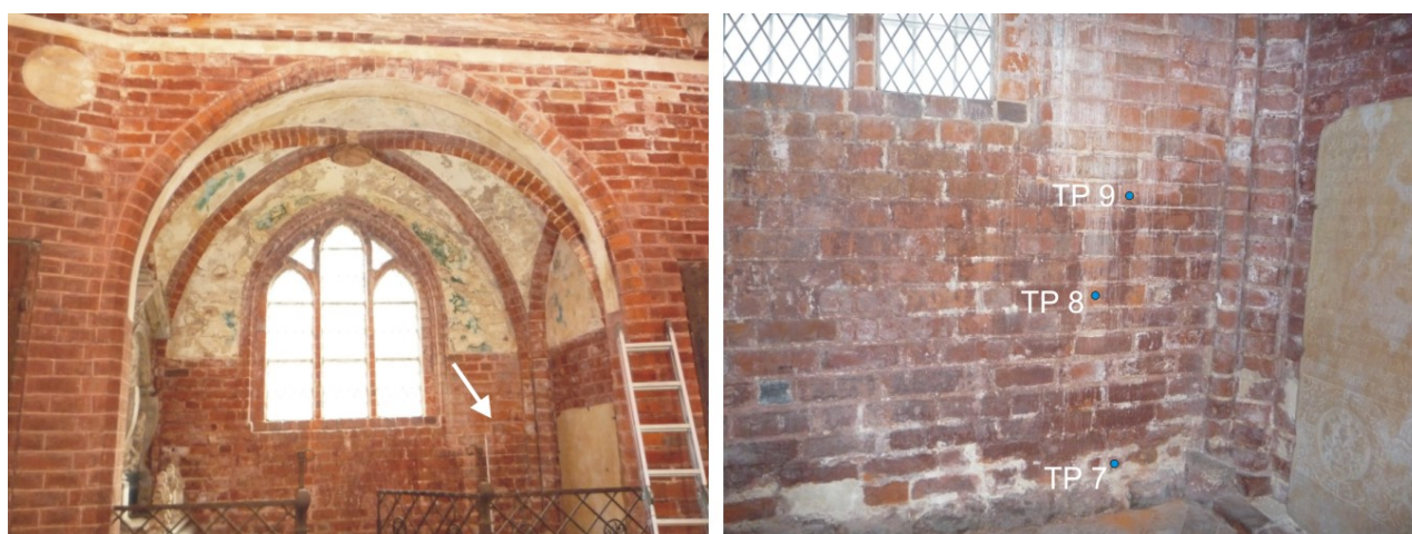
Abb. 7: Position der Tiefenprofile TP 7, TP 8 und TP 9), Südwand des Kirchenschiffes, Rückwand der Seitenkapelle, westlich des Fensters
