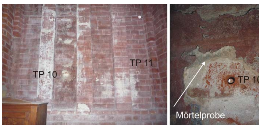
Abb. 12: Lage der Tiefenprofile TP 10 und TP 11 und Entnahmestelle der Mörtelprobe benachbart zu Tiefenprofil TP 10, das komplett durch den Wandquerschnitt gebohrt worden ist (15 cm).
